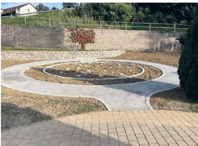
Während der Arbeiten (Stand 13.7.2023)
